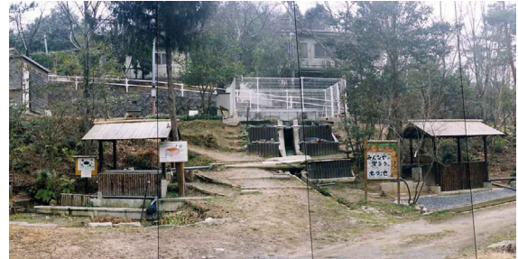
図－1 水浄化システム全景
