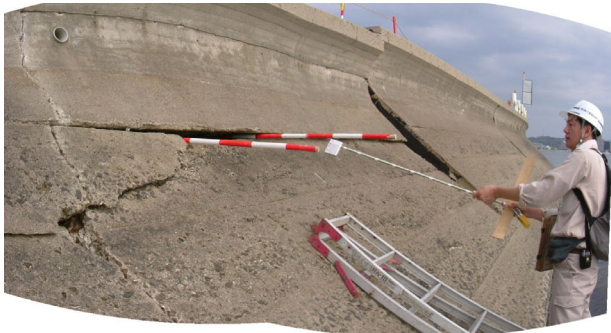
写真-2 打ち継ぎ目亀裂からの空洞状況調査状
