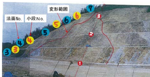
写真-2 工事中の法面写真。丁張と小段および法面の段数を参考にして変形範囲を記入した。
