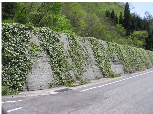
写真-4 事例③ 写真
