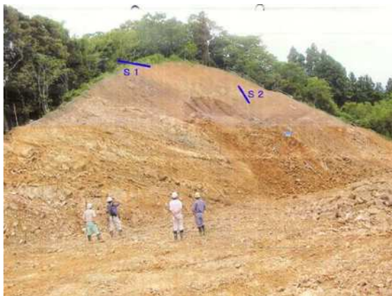
写真-1. 現場全景
