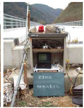
写真-3. 観測 BOX 設置状況
