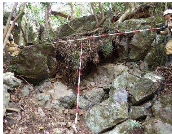
写真-3 現地写真(落石源)の様子
