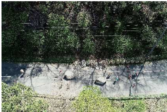
写真-1 被災状況
