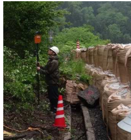
写真-2 現地計測状況
