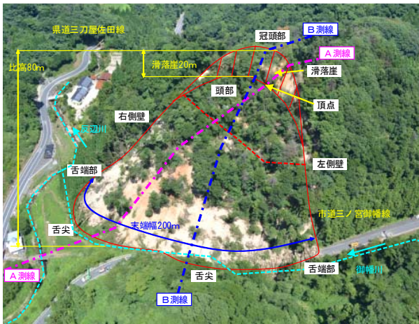
写真-1 御幡地すべり全景
