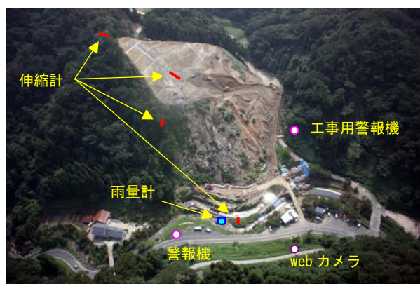
写真-2 施工時の安全管理
