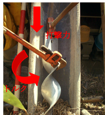
写真-2 ハンマによる打撃
