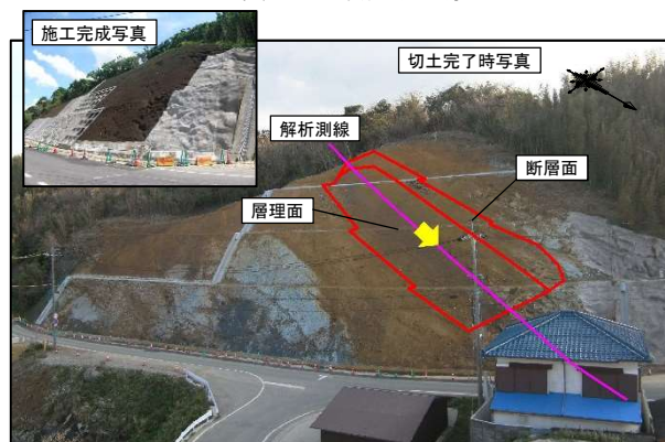
写真-2 切土時の写真(崩壊の6年前)(左上 施工後写真)
