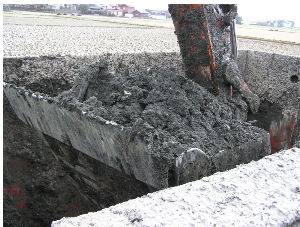
写真-2 泥土の固化処理状況
