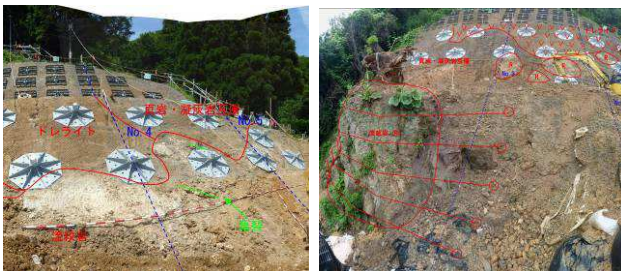
写真-3 法面観察
