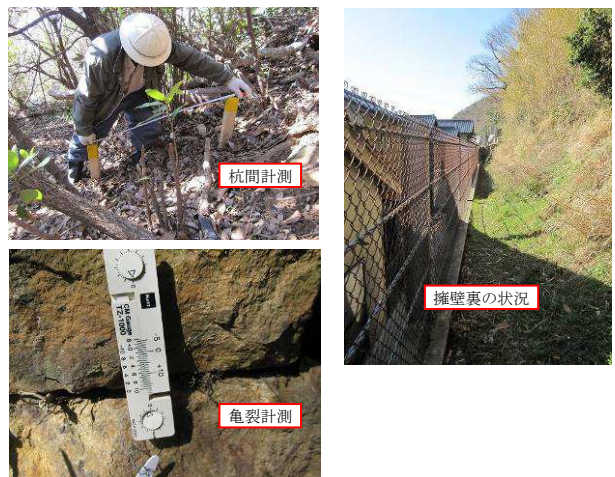
写真-2 定期点検
