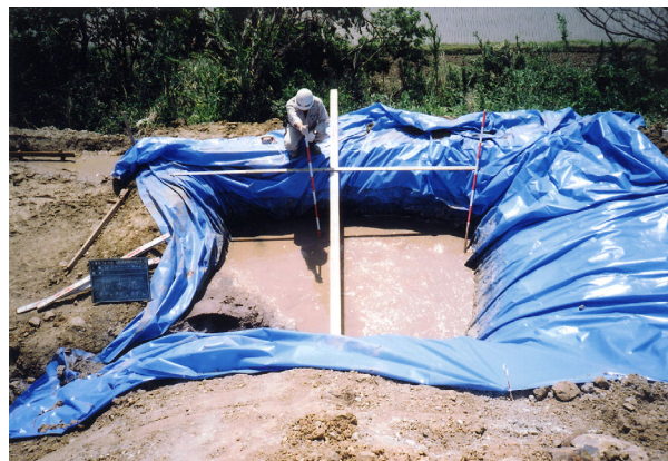
写真二 排水ボーリング現場の沈殿池
