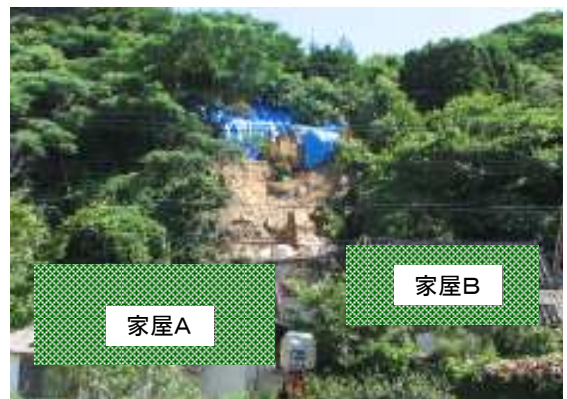
写-1 崩壊地全景
