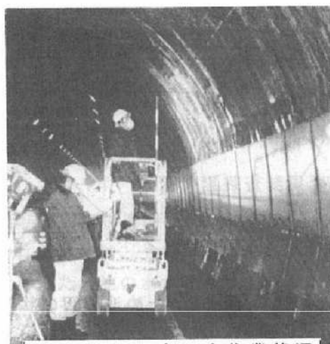
写真-1 トンネル内作業状況
