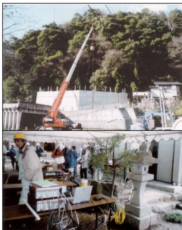
写真 1 実験現場の全景と計測状況
